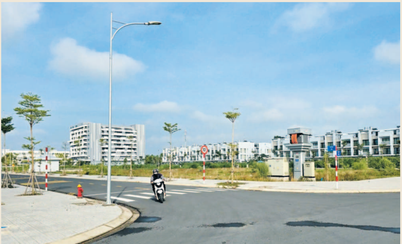
Khu tái định cư thuộc Khu đô thị đường Nguyễn Văn Cừ, TP.Cần Thơ đã hoàn thành
