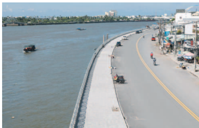
Dự án kè sông Cần Thơ - ứng phó biến đổi khí hậu TP.Cần Thơ có tổng chiều dài toàn tuyến gần 5,2km
