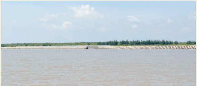
Dự án kè chống sạt lở Cồn Ngang (huyện Tân Phú Đông) hoàn thành vào Quý 3/2024
