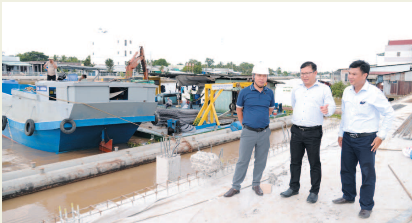
Giám đốc Nguyễn Đàm Thanh Tuyền (đứng giữa) trao đổi với nhà thầu thi công dự án xử lý các đoạn sạt lở cấp bách trên sông Cái Bè (kênh 28). Ảnh: Báo Ấp Bắc, tư liệu tháng 9/2024
