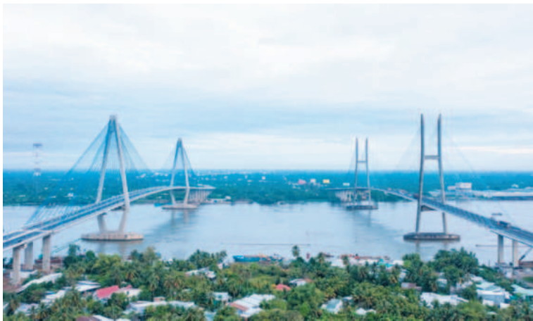
Cầu Mỹ Thuận và Cầu Mỹ Thuận 2 giúp nâng cao khả năng kết nối của tỉnh Tiền Giang nói chung, huyện Cái Bè nói riêng
