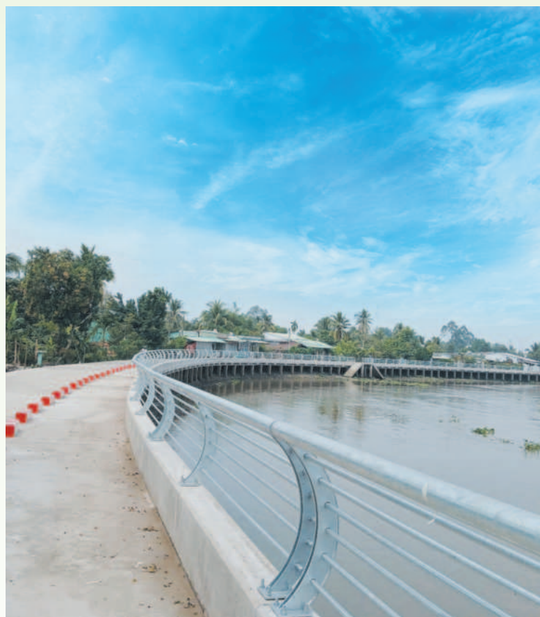
Một đoạn công trình thuộc Dự án xử lý các đoạn sạt lở cấp bách trên sông Cái Bè (kênh 28, huyện Cai Lậy, Tiền Giang) do Công ty 116 thi công
