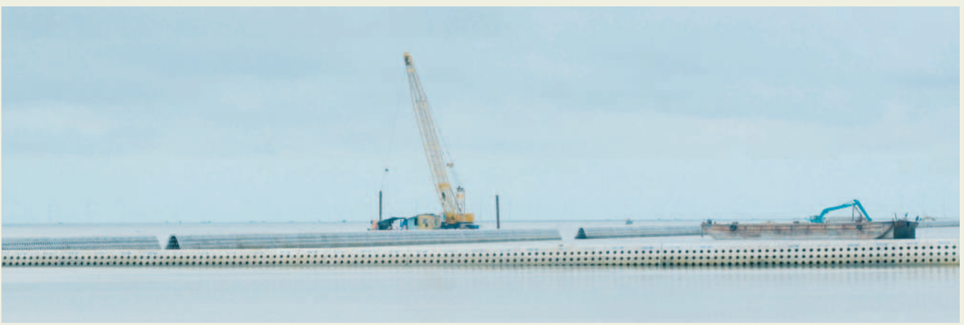
Dự án nâng cấp đê biển Gò Công giai đoạn 2 đã hoàn thành, đưa vào sử dụng vào tháng 10/2023
